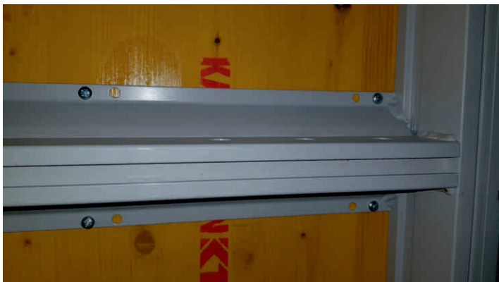
Schalhaut d=21 mm von hinten mit SH Schraube 7x21 mm verschraubt
