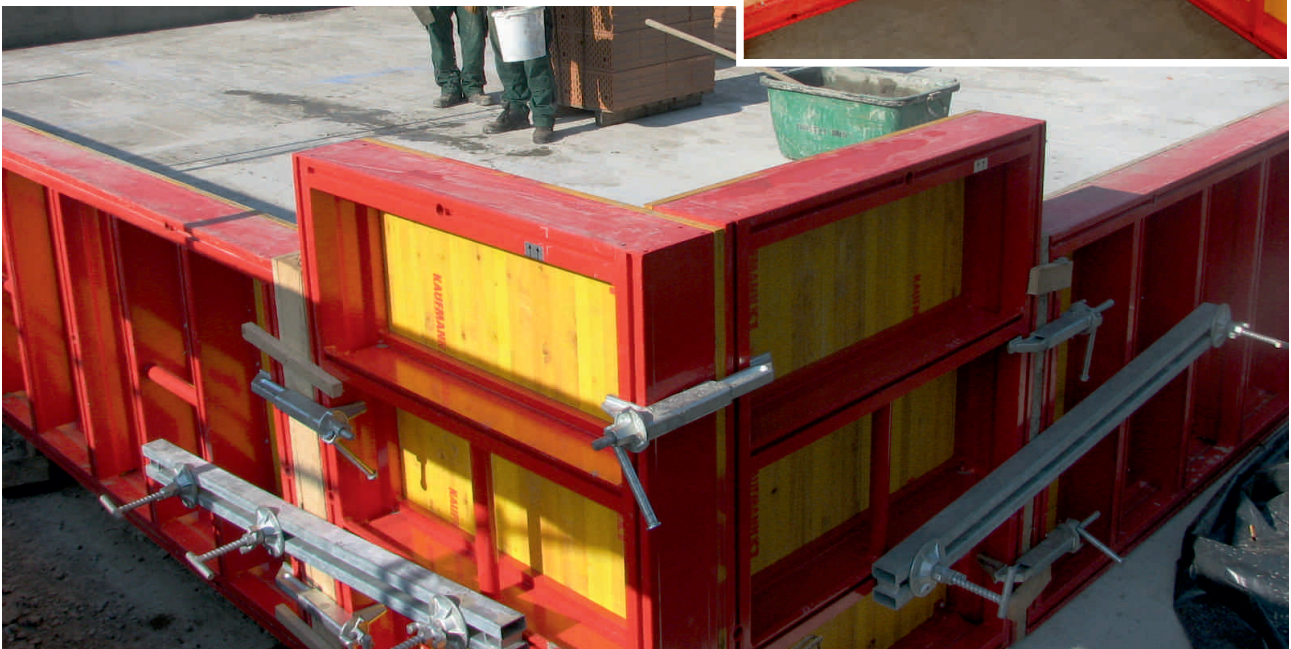
▼ Ecklösung AluMAX mit MST Schraubzwinde
