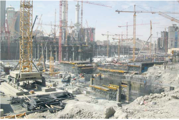
Die Expansion der al-Haram-Moschee ist in vollem Gange, zwei neue Minarette sind gerade im Bau.
