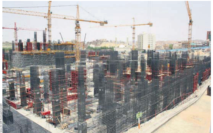
Die Hälfte aller angelieferten Produkte sind Spezialfertigungen, im Bild zu sehen ist die GHI-TriTec-Säulenschalung.
