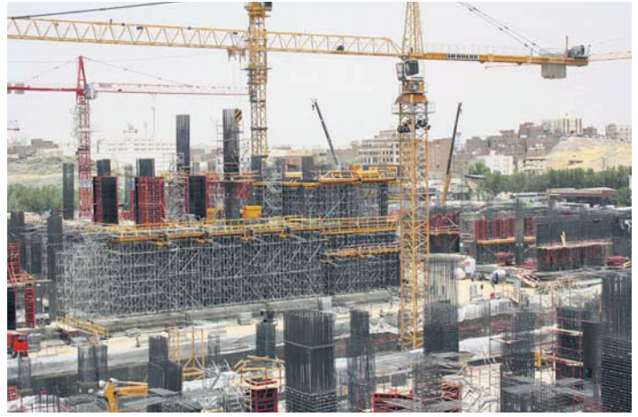
Insgesamt liefert GHI Formwork rund 250.000 Quadratmeter Wand- und Deckenschalung.
