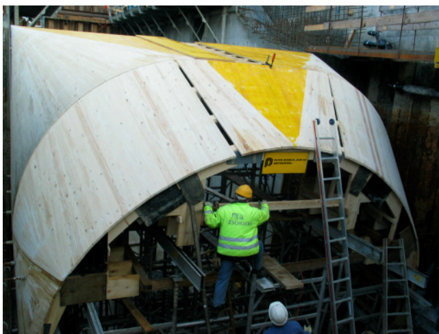
Einlaufschalung - Wasserkraftwerk Baden
