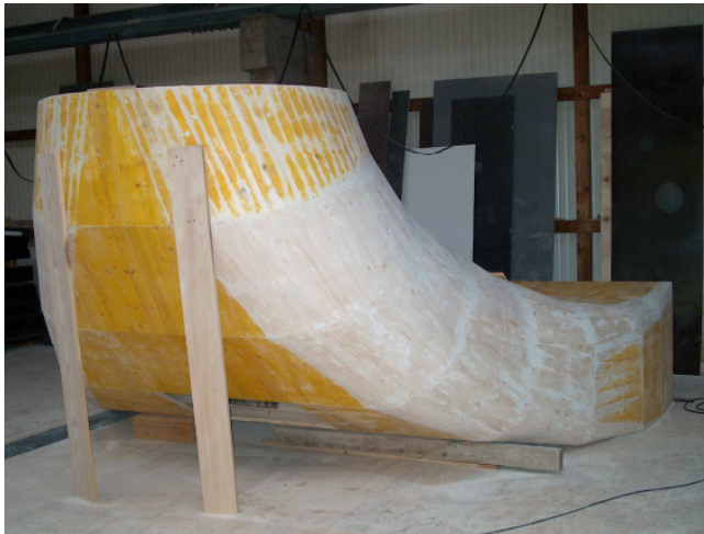
Saugrohrschalung - Wasserkraftwerk Thur
