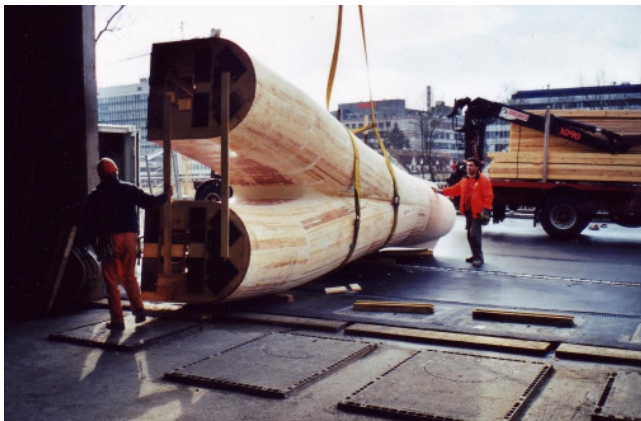
Zwillingsrohrschalung - Flussverbauung Glatt
